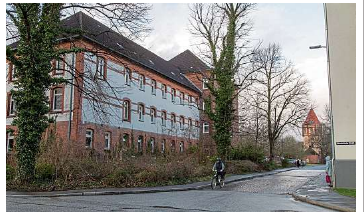
Nur die schmalen Fenster des roten Backsteinhauses an der Ecke Rostocker Straße/Weimarer Straße lassen erahnen, dass hier das Marineuntersuchungsgefängnis untergebracht war.
